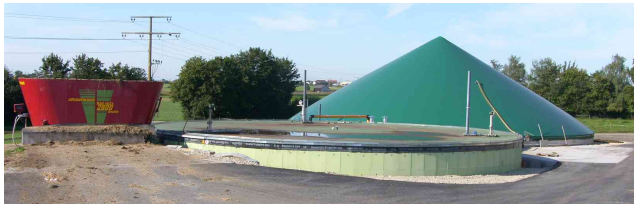
Biogasanlage Helmut Schaff, Tuningen
