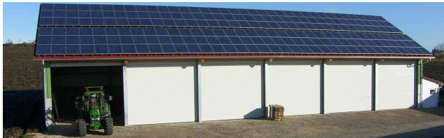
Maschinenhalle mit Photovoltaikanlage Schöndienst, Trossingen – Schura
